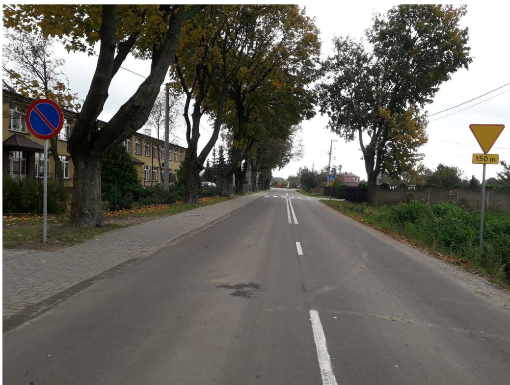
Przebudowa drogi powiatowej nr 2112W Zamość - Rawy - Sypniewo, odcinek o długości 300 mb
