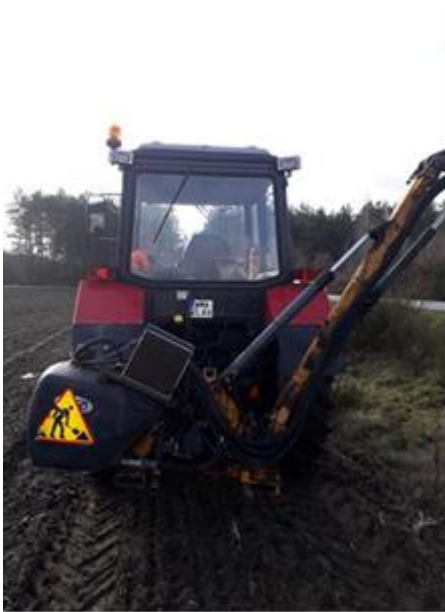
Wycinka mechaniczna rowów (w tym krzewów) przez pracowników Zarządu Dróg Powiatowych w Makowie Mazowieckim w ramach bieżącego utrzymania dróg powiatowych
