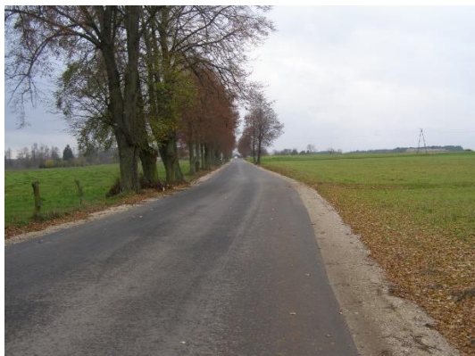
Przebudowa przepustu na obiekt mostowy w miejscowości Rupin na drodze powiatowej nr 2105W Sieluć - Rupin-Guty Duże – ETAP II na odcinku o długości 0,575 km
