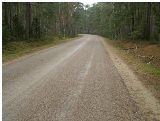
Przebudowa drogi powiatowej nr 2114W Mamino – Glinki – Rafały na odcinku o długości 4,500 km – etap I w 2020 r. o dl. 0,700 km
