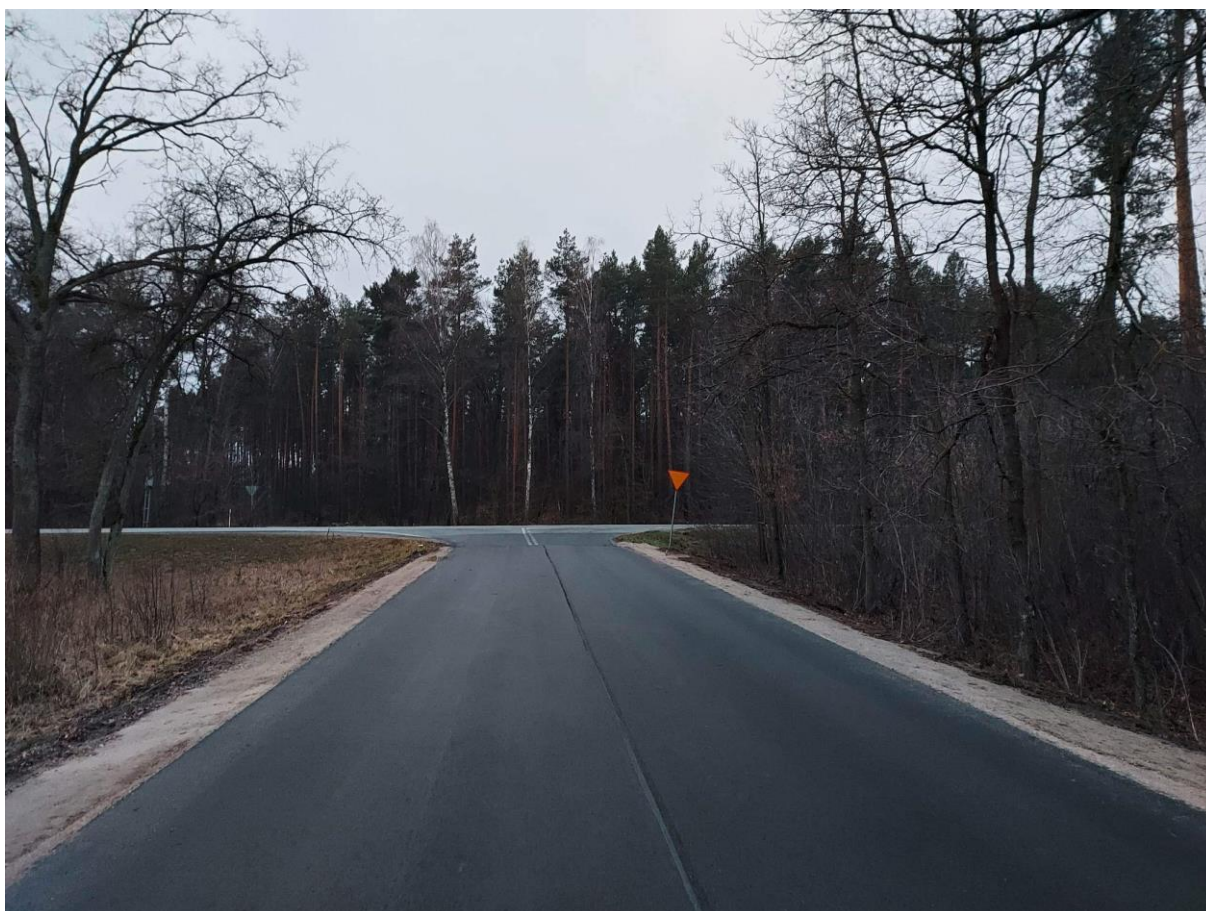
Przebudowa drogi powiatowej nr 2102W Kaszewiec - Chelsty - Jawory Stare na odcinku o długości 4,350 km zadanie rozpoczęte i zakończone w 2022 roku
